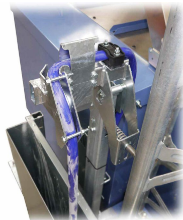
Abb. 26: Verlegung am Kabelhalter
